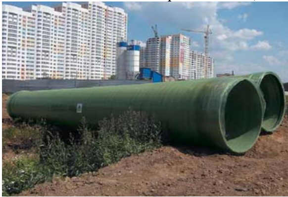
Рис. 7. Использование композитных материалов для производства элементов инженерных систем: а) трубы для системы водоснабжения; б) запорная арматура
