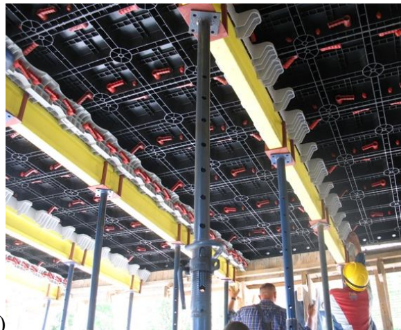
Рис. 8. Опалубка из композитных материалов: а) для бетонирования стен; б) для бетонирования перекрытий
