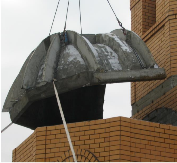
Рис. 6 Монтаж алтарного и цилиндрического свода
